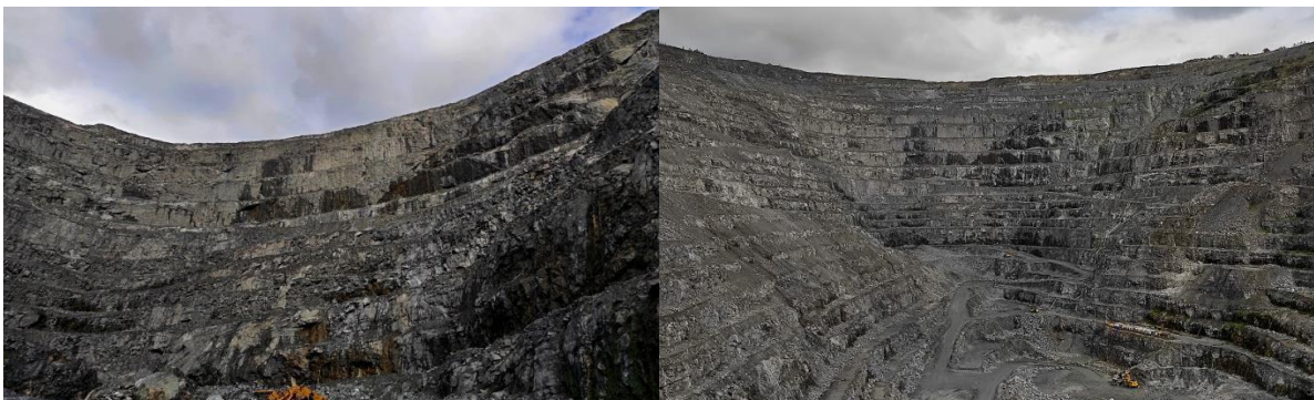
Сурет. 1. ЗКВ-Б пайдалана отырып, түпкілікті жағдайға қойылған "№6" карьер борттарының учаскелері
