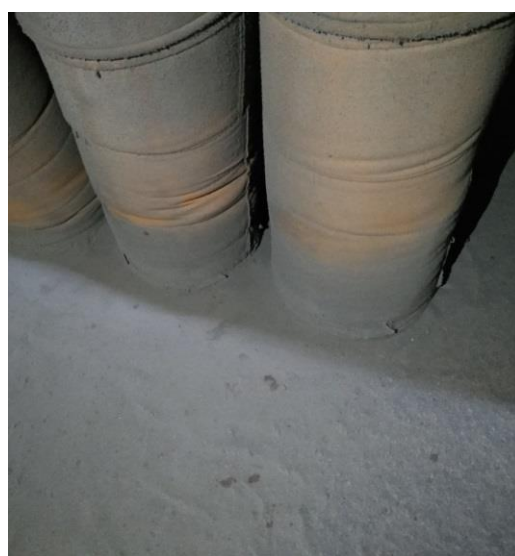
Рисунок 5 – Нижнее крепление рукавов
