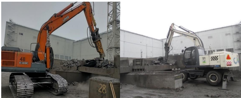
Рисунок 1 – Процесс первичного дробления гидромолотом
