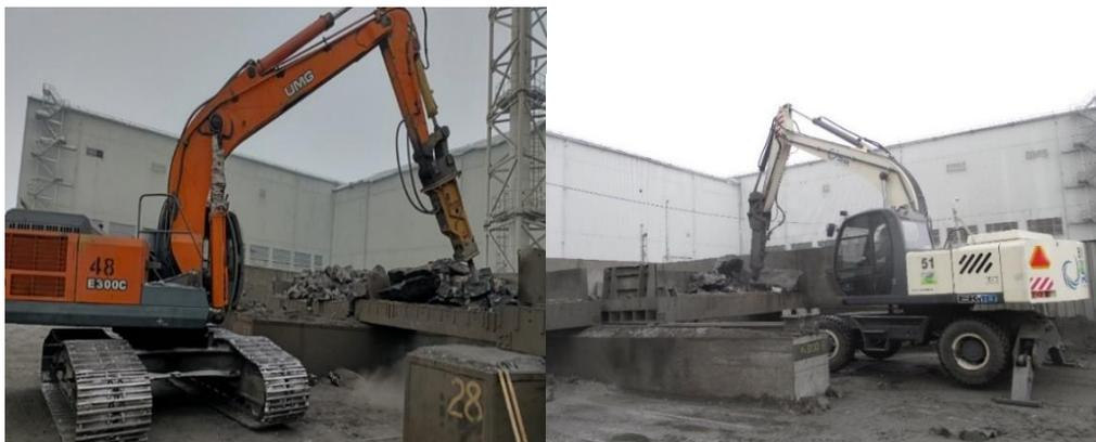
**Рисунок 1 – Процесс первичного дробления гидромолотом**
