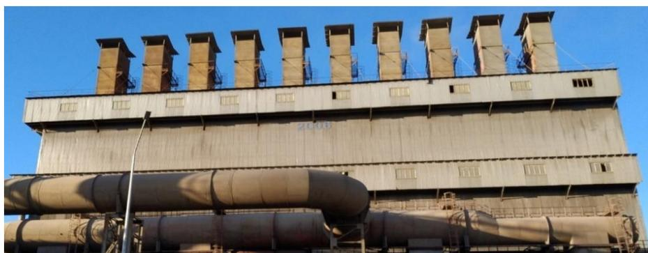
**Рисунок 8 – Вытяжные шахты для выхода очищенного газа
