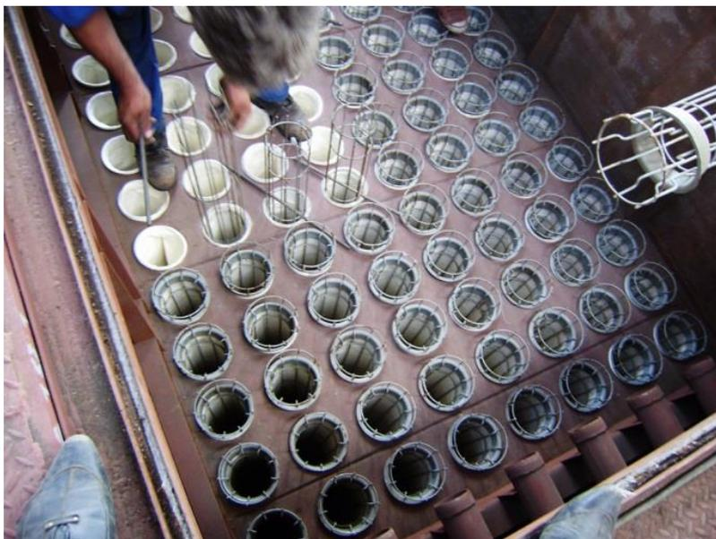
**Рисунок 12 – Одностороннее верхнее крепление рукавов**
