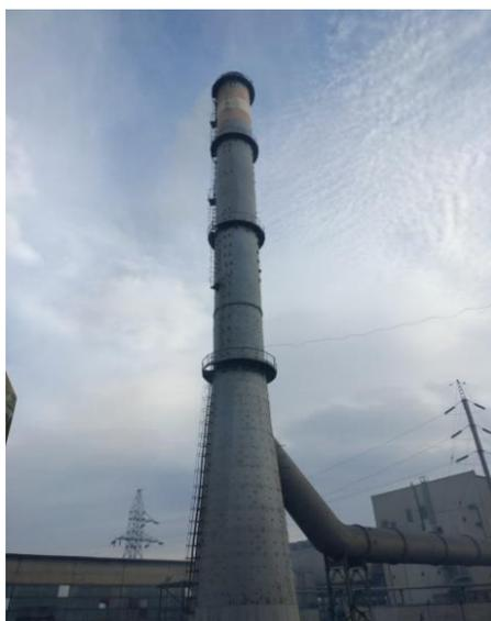
**Рисунок 13 – Дымовая труба для сосредоточенного выброса газов**
